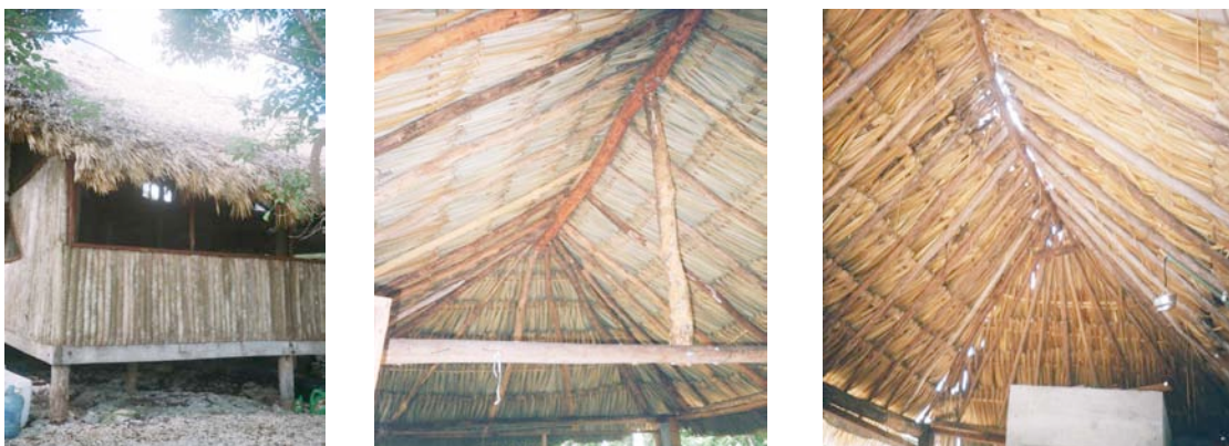
Figura 4. Reparación de techos en las diferentes estructuras
