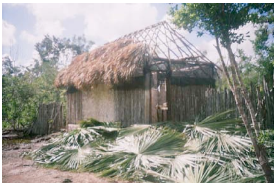
Figura 5. Reparación de los baños de los trabajadores (50%)
