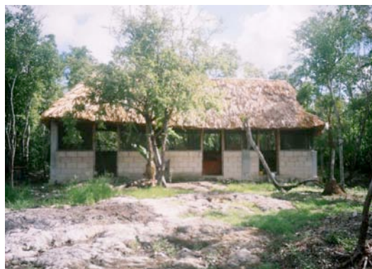
Figura 6. Reparación de las palapas de los trabajadores (100%)
